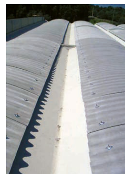
Protezione anticarbonazione del calcestruzzo (trave ad Y)
