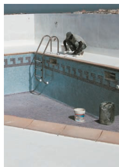
Impermeabilizzazione di terrazze e piscine
