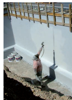
Impermeabilizzazione di muri di fondazione
