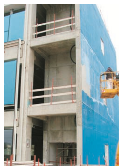
Protezione e decorazione delle facciate in calcestruzzo
