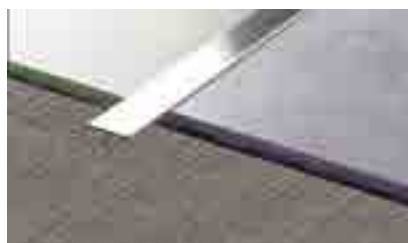
Installazione del profilo a "T"
