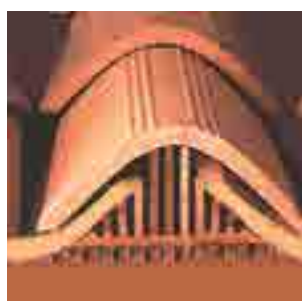
Esempio di applicazione fermapasseri sottotetto
